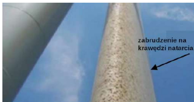
Rysunek 5. Wpływ zabrudzeń na pracę turbin wiatrowych
